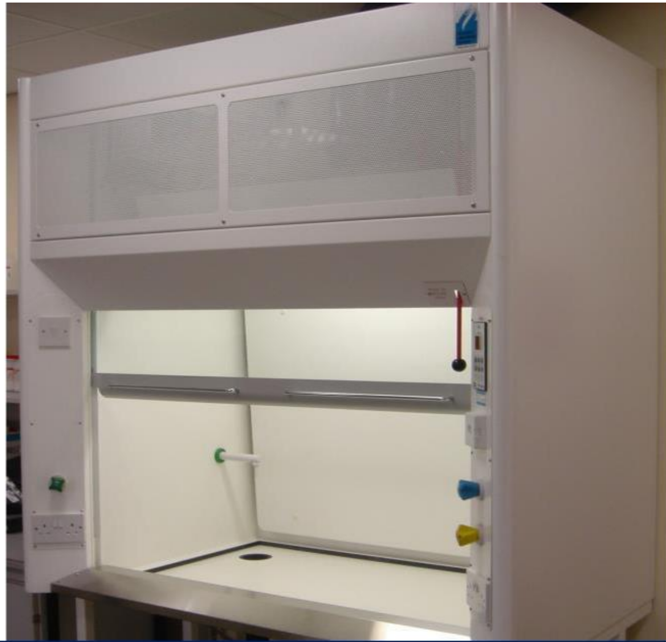
Bir duman dolabı, örnek; lokal aspiratör sistemi
